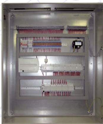
Щкаф с модульными контроллерами серии PXC
