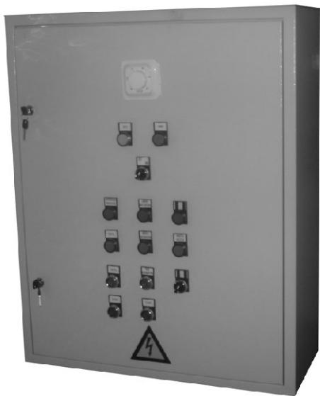
Регулировка температуры приточного воздуха при помощи симисторного регулятора TTC40F и шагового регулятора температуры TT-S6/D фирмы Regin.
