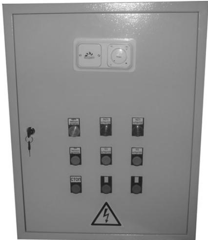
Регулировка температуры приточного воздуха при помощи симисторного регулятора МРТ380.14 и блока расширения мощности БРМ-40.
