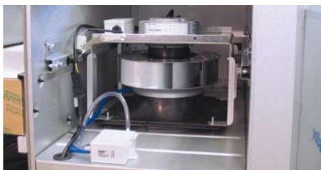
Вентиляторы с непосредственным приводом с двигателями постоянного тока ЕС
